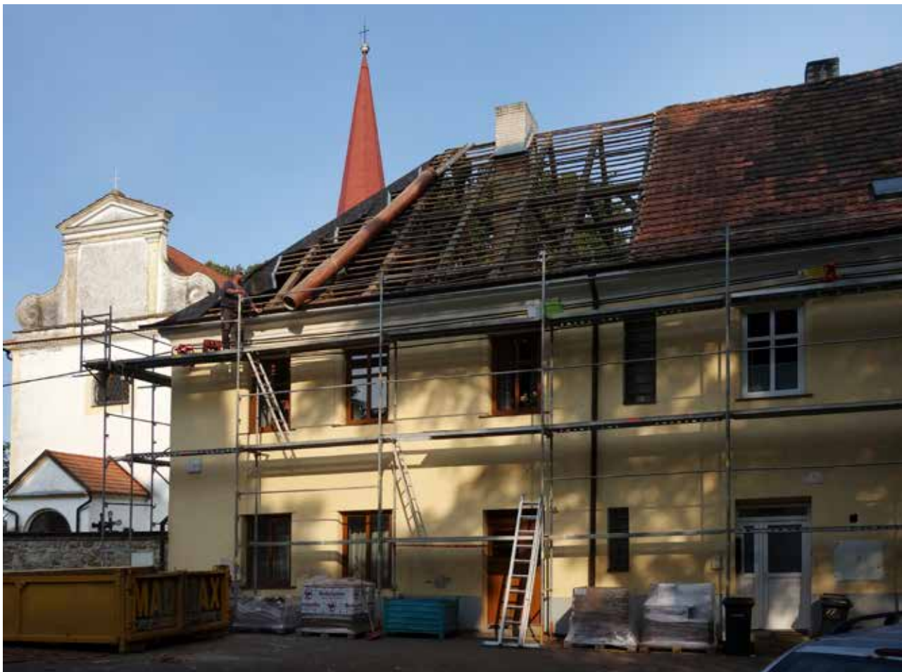
Z kraje srpna započala v Dubu výměna střechy bývalé fary
